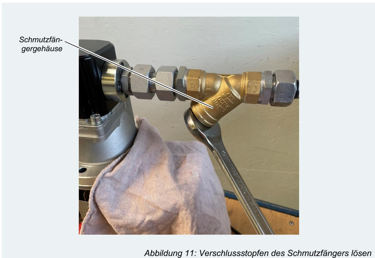
Abbildung 11: Verschlussstopfen des Schmutzfängers lösen
