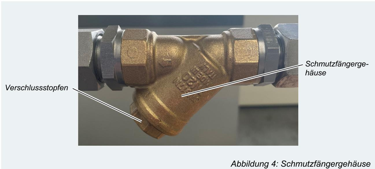
Abbildung 4: Schmutzfängergehäuse
